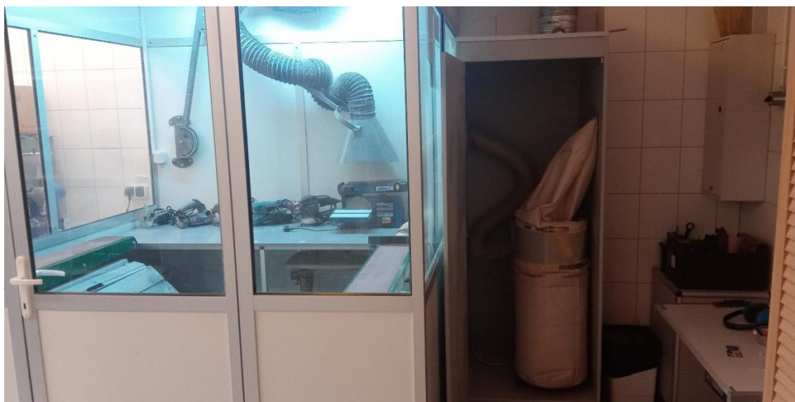
Ryc. KULDiEL 2. Odseparowana kabina ze szlifierkami oraz wyciągami trocin, wiórów i pyłu
